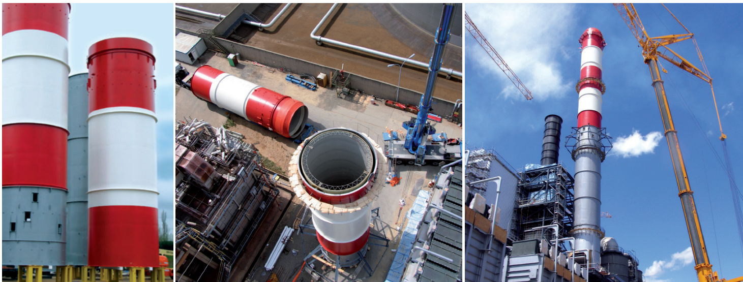
De izquierda a derecha: Pasos de la instalación de la chimenea.
