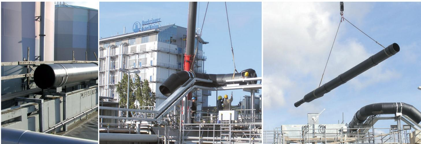
Sobre una red de puentes para tubos, los tubos se mantienen estables. Numerosos componentes especiales permiten una adaptación individual a las circunstancias.
