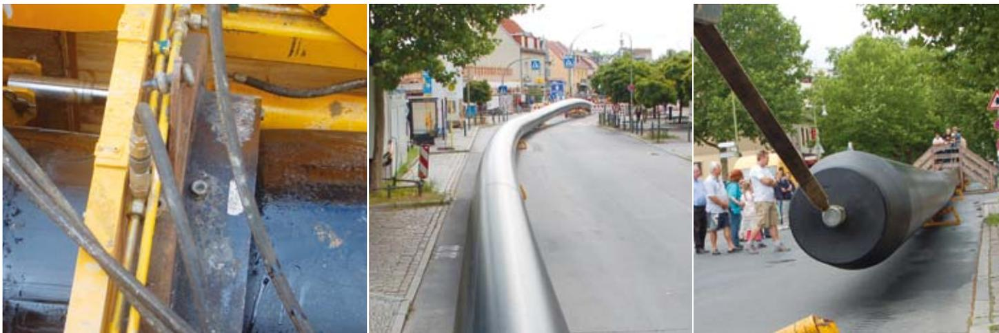
Izquierda: Los haces de tuberías se soldaron entre sí mediante soldadura a tope con elementos calefactores y con arrastre de fuerzas longitudinales. Centro: El haz de tuberías de 500 m de longitud se introdujo en la tubería antigua en un solo paso. Derecha: Con equipos de construcción ligeros, se pudo transportar todo el haz de tuberías hasta el foso inicial.
