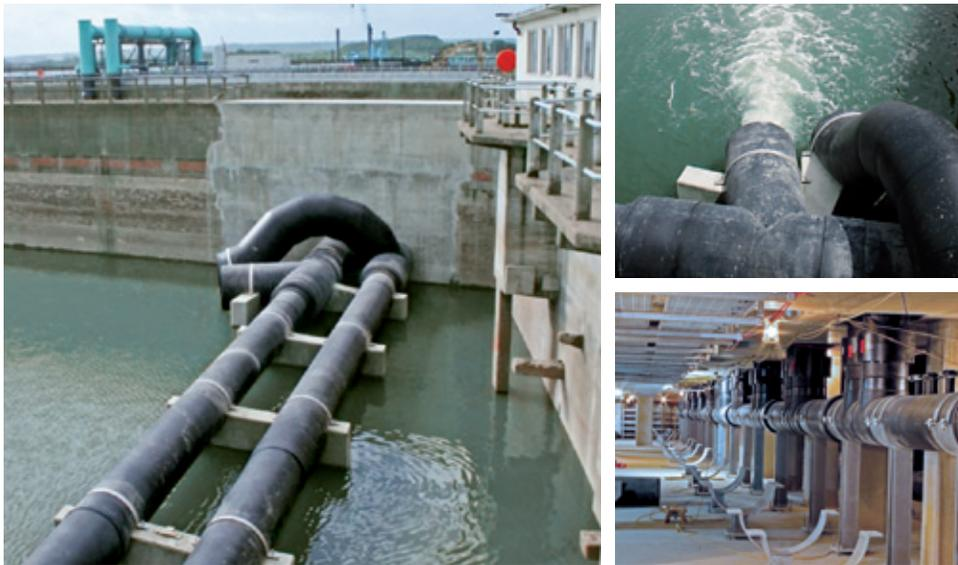
izq.: Grandes tubos de entrada de SIMONA® PE 100; d. sup. Estanque de almacenamiento de aguas salobres con tubo de entrada de PE 100 de 1.000/1.200 mm de diámetro; d. inf. Línea colectora de PE 100 erigida sobre el suelo bajo el módulo de filtración
