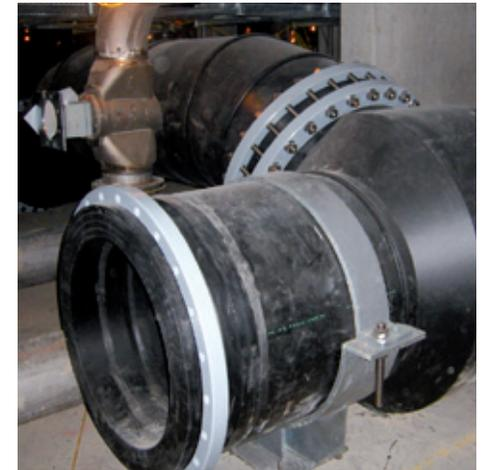
Columna soldada de PE 100 de 900 mm de diámetro SDR 17, incluida pieza en T reforzada de PN 10
