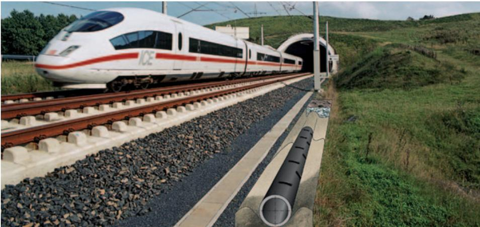
Foso de infiltración abierto con tubería ranurada 2/3 SIMODRAIN®
