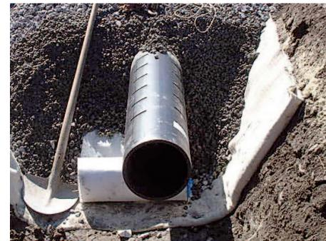
Recubrimiento de la capa de gravilla de filtrado con un geotextil
