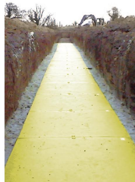
Figura 4: Planchas de protección instaladas sobre un conducto de gas
