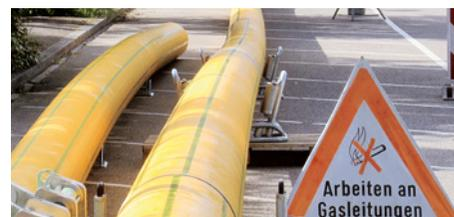
Tramo de tubería pre-soldado para la inserción de tuberías
