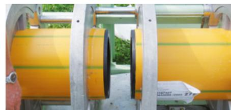
Soldadura a tope de las tuberías con recubrimiento
