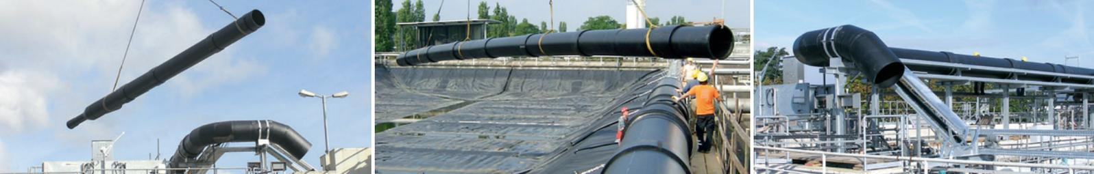
Photos, de g. à dr. : une grue automotrice de 250 tonnes et d'une portée maximale de 70 mètres soulève les éléments sans effort. Les éléments tubulaires pré-soudés raccourcissent le temps de montage.
