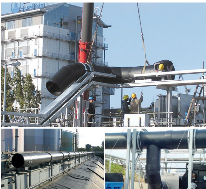
*Les tubes sont positionnés et bien maintenus sur un réseau de ponts pour conduites. De nombreuses pièces spéciales permettent un ajustement customisé à la configuration locale.*
