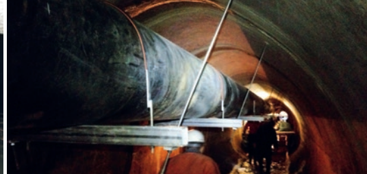
De g. à dr. : Stockage des tubes SIMOFUSE®; supports spéciaux et dispositifs d'appui pour les tubes SIMOFUSE®; tube suspendu dans la canalisation à section ovoïde
