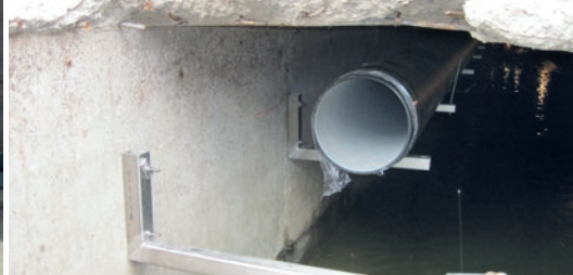
De g. à dr. : Stockage des tubes SIMOFUSE®; supports spéciaux et dispositifs d'appui pour les tubes SIMOFUSE®; tube suspendu dans la canalisation à section ovoïde
