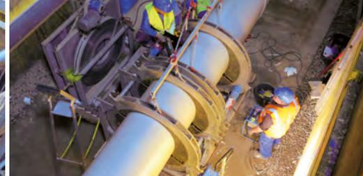
V.l.n.r.: Einbringen des werkseitig geschweißten 7,5 m Modules in die Baugrube und Anschweißen an den Rohrstrang für den Relining-Einzug
