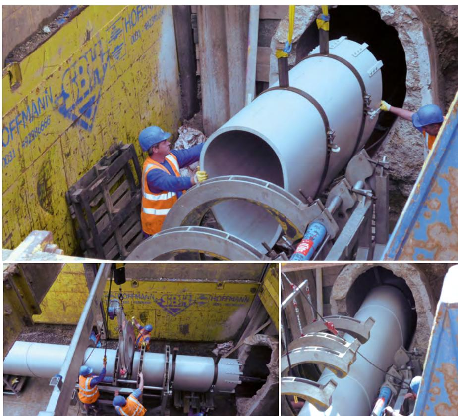
Oben: Einlassen des Zugkopfes zum Anschweißen an den Eiprofil-Strang inkl. Abstandshalter; unten links: Einbringen des Hobels und Vorbereitung zum Verschweißen von Zugkopf und Eiprofil; unten rechts: Einzug des Eiprofil-Stranges
