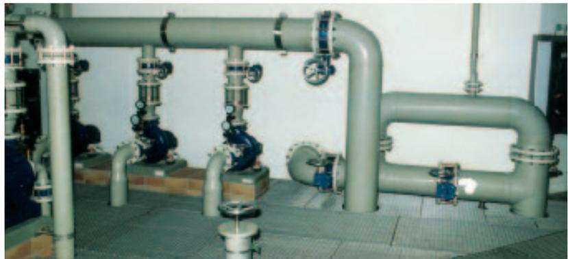
Pumpen mit Anschlüssen an die PP-H 100 Rohrleitungen.
