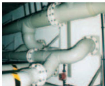
PP-H 100 Rohrleitungen zur Entnahme des Trinkwassers.
