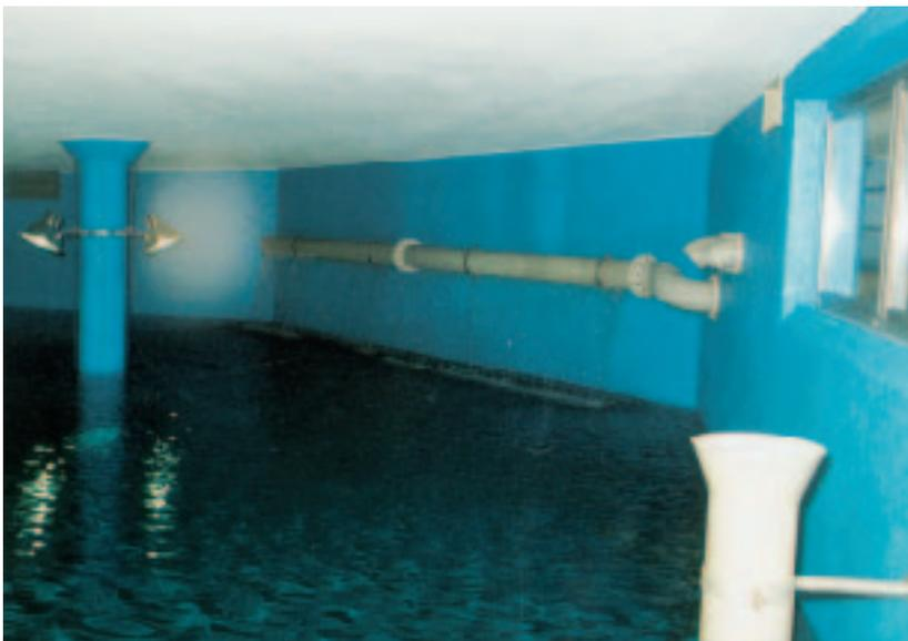
Der Reinwasserbehälter mit den Ein- und Ausläufen aus PP-H 100 Rohren.
