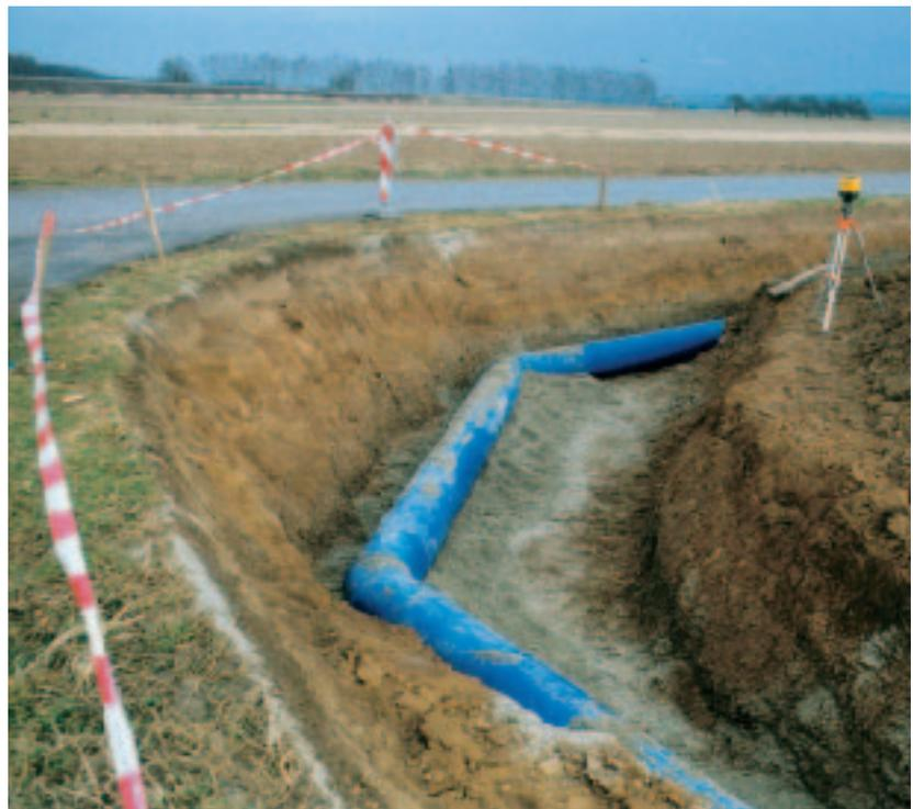
Richtungsänderung von  $90^\circ$  mit zwei  $45^\circ$  Bögen ( $d = 500 \times 45,5$  mm), hergestellt aus durch Heizelementstumpfschweißung nach DVS 2207 Teil 1
