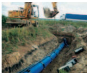
Mit dem vormontierten PE 100 Rohr werden gleichzeitig zwei PE-Kabelschutzrohre (d = 90 mm) eingezogen.
