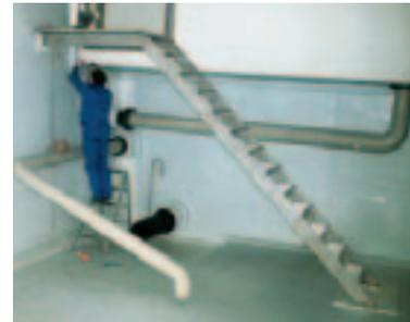
Einbau der Zu- und Entnahmeleitungen aus PP-H 100  $d = 225 \times 12,8 \text{ mm}$  in SDR 17,6 (PN 6).
