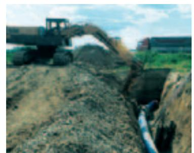
Durch Heizelementstumpfschweißung wird das PE 100 Rohr an der Ostseite der Autobahn A5 an den dortigen Rohr-
