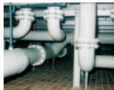
PP-H 100 Verrohrung mit Flanschverbindungen und Halterungen.
