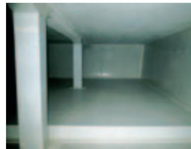
Die mit SIMONA PE-HWST natur Platten ausgekleidete fertige Wasserkammer.
