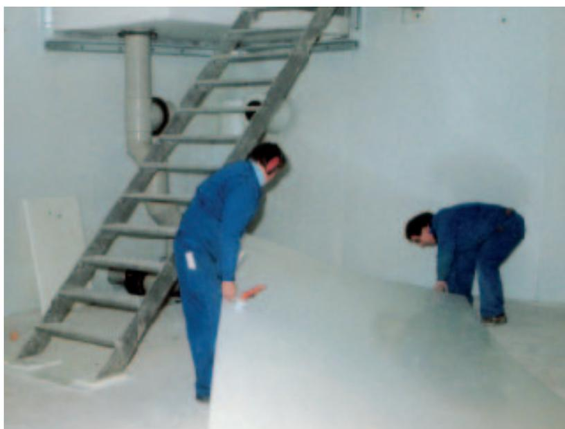
Die eingepaßten Platten werden an der Betonwand und am Boden verschraubt.
