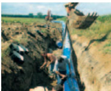
Das PE 100 Rohr wird mit Gleitkufen zum Einziehen in das Pressrohr DN 700 vorbereitet.
