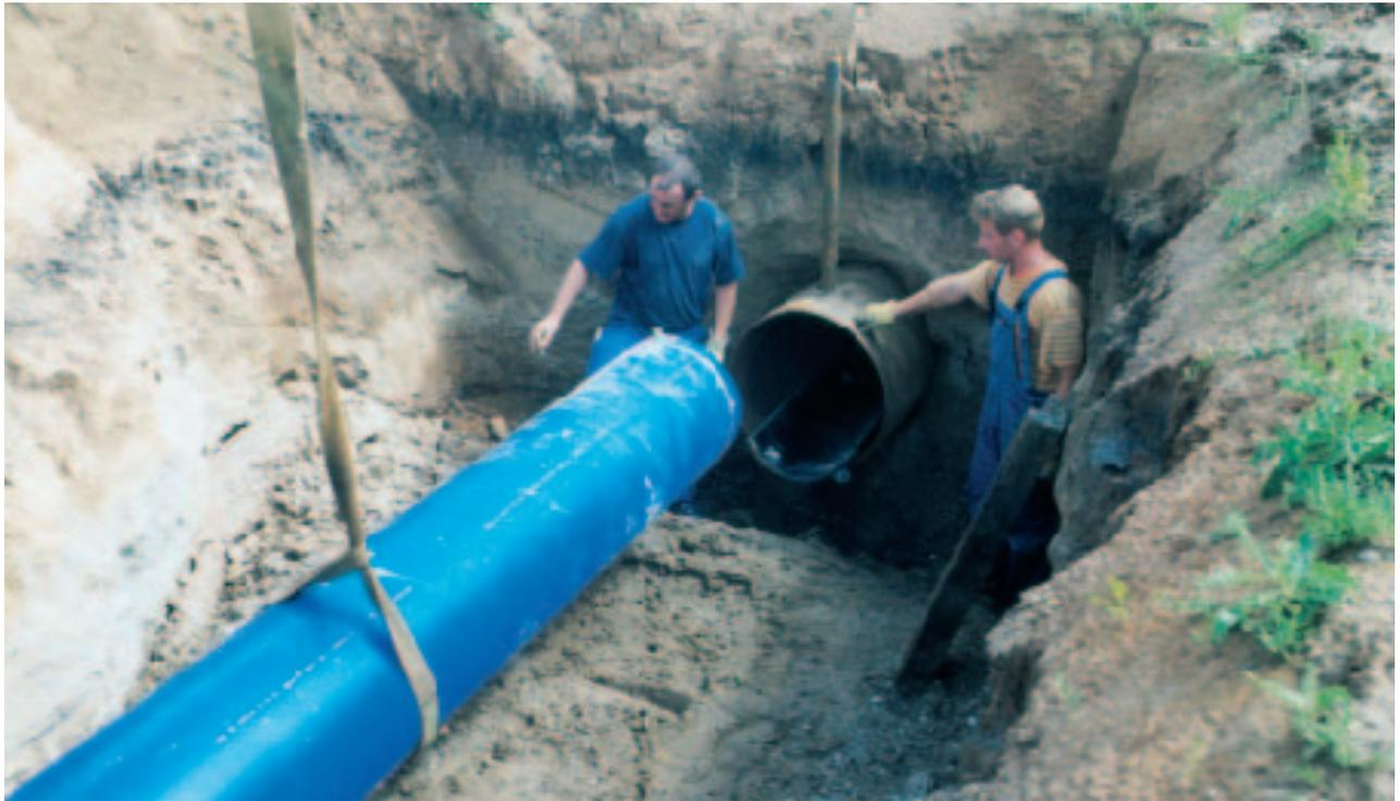
Das Spitzende des PE 100 Rohres wird beim Einschieben auf einen Spezialwagen gelagert, damit das Rohrende gegen Beschädigungen geschützt ist.
