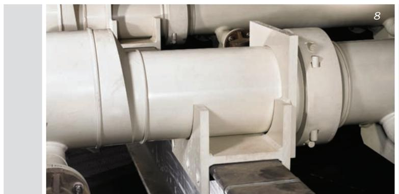
Les buses tuyères ont été fixées avec les conduites d'alimentation par des raccords à bride. Elles se trouvent sur les poutres métalliques et sont mobiles an plan axial.
